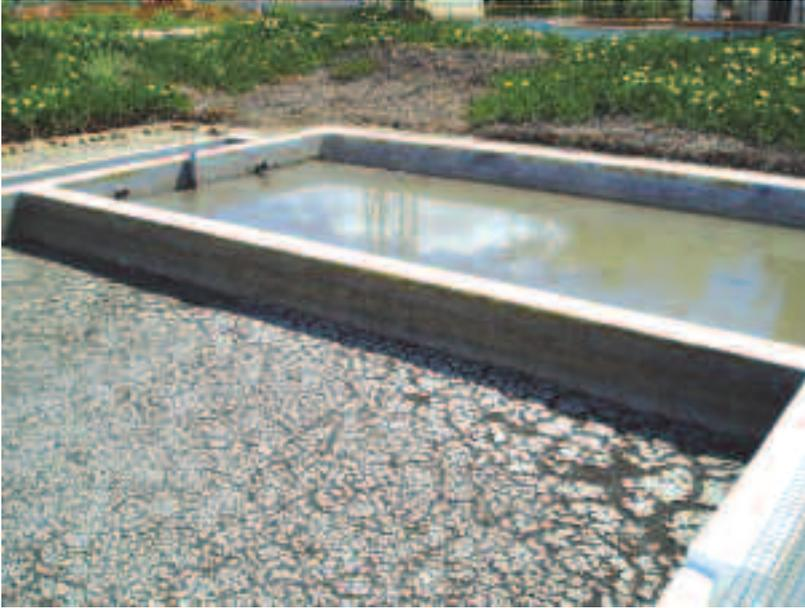
**Photo 5.16.** Détail de Filtres de Tourbe en fonctionnement ( inondés ) et en régénération ( séchage de croûte superficielle ). PECC.
