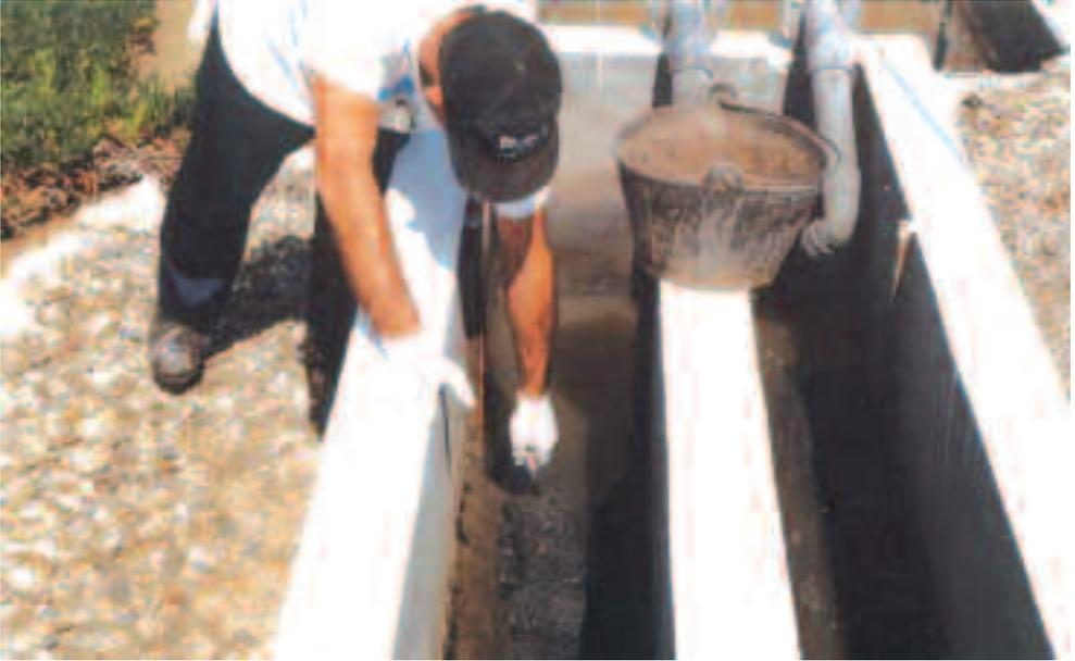
Photo 5.4. Nettoyage manuel des canaux dessablés. Évacuation des sables extraits.
