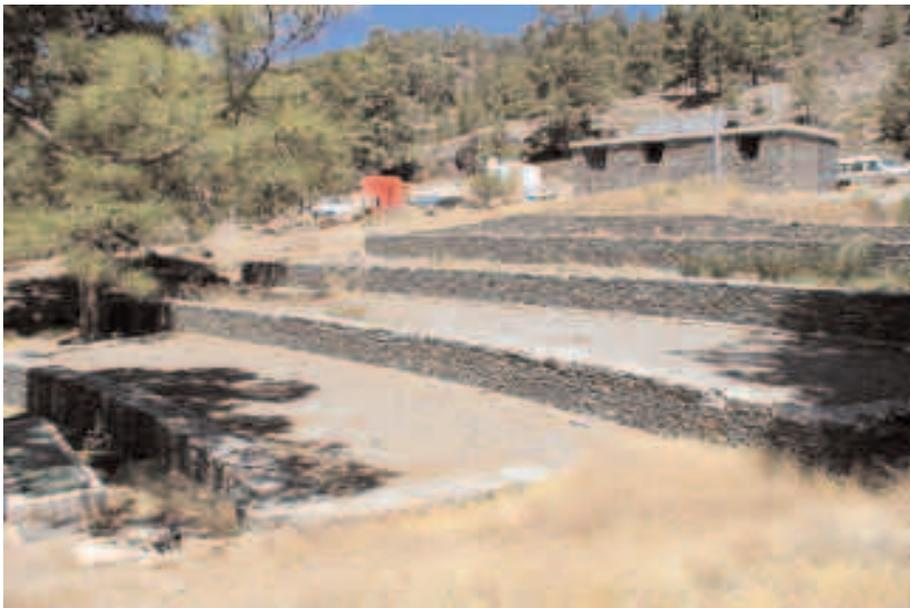
**Photo 5.11.** Milieu Humide Artificiel à Flux Hypodermique Horizontal. SEER Zone de Loisirs de Las Niñas ( La Grande Canarie - Las Palmas ).
