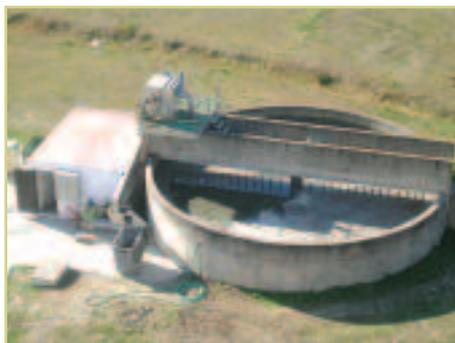
Foto 3.14. Estabilización anaerobia de lodos. EDAR de Manilva (Málaga)
