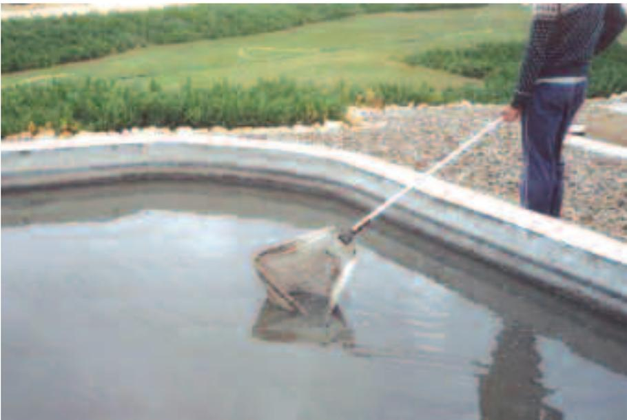
**Photo 5.15.** Nettoyage de solides flottants en surface du Bassin Anaérobie.
