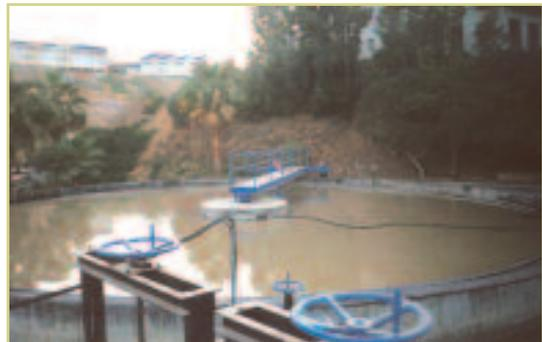
Photo 3.8. Détail de traitement physico-chimique ( chambre de floculation-coagulation ). SEER d'El Rompido ( Huelva )
