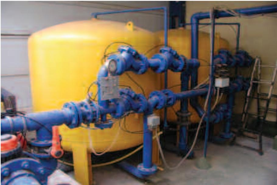
**Photo 5.25.** Filtres de Sable. SEER AENA Arrecife ( Lanzarote - Las Palmas ).
