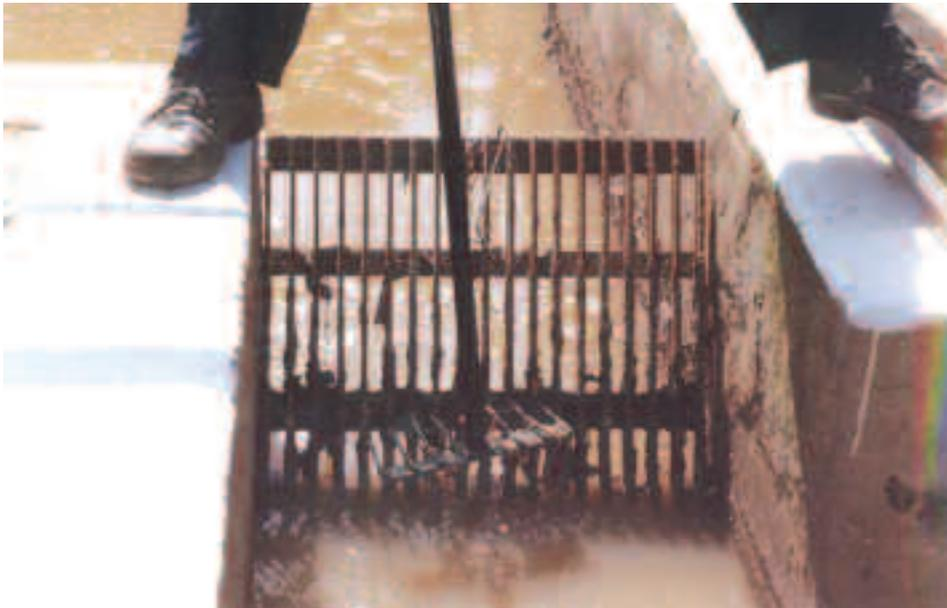
Photo 5.3. Nettoyage manuel des grilles de dégrossissage.
