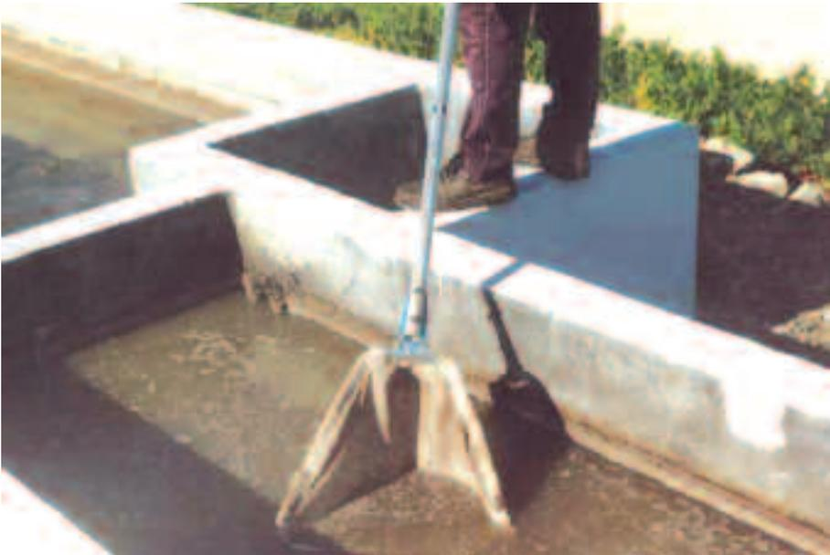
Photo 5.5. Extraction de graisses dans le Dégraisseur.
