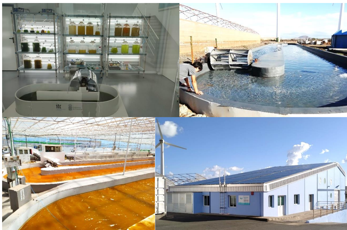
Figura 4. Imágenes de las instalaciones del Instituto Tecnológico de Canarias en Pozo Izquierdo (Santa Lucía de Tirajana, Gran Canaria, España). De izquierda a derecha y de arriba hacia abajo: Cámara de cultivo para el mantenimiento y el escalado 'indoor' de las microalgas; fotobiorreactor de cultivo del tipo raceway de 300 m 2 de superficie al exterior; raceways de 80 m 2 bajo invernadero de 1500 m 2 ; nave de procesamiento y post-procesado de la biomasa, con cubierta fotovoltaica conectada a batería como parte del sistema de integración de la microrred eléctrica inteligente.
