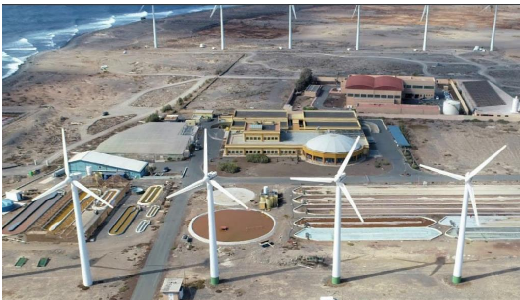
Figura 2. Vista aérea de las instalaciones del Instituto Tecnológico de Canarias (ITC) en Pozo Izquierdo (Santa Lucía de Tirajana, Gran Canaria, España).
