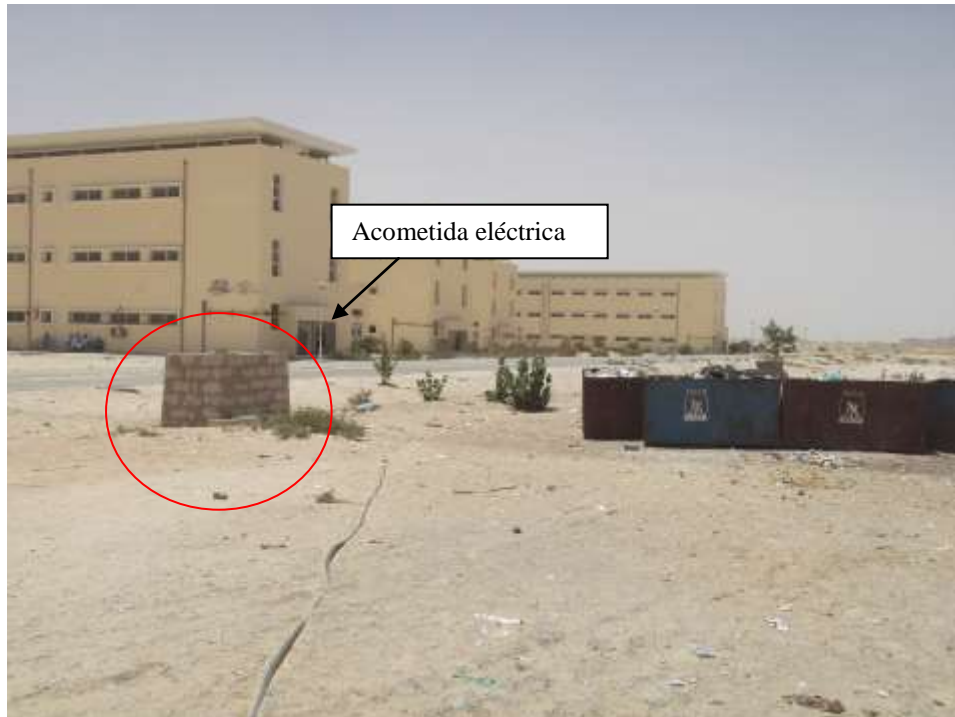
Figura 3. Acometida eléctrica y toma de agua.
